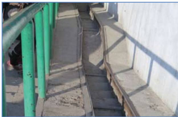
Подземный пешеходный переход. Чиланзарский район
