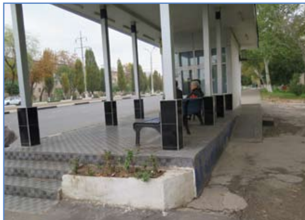
Остановка в Мирзуюлукбекском районе
