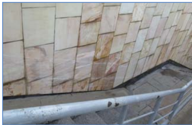
Подземный пешеходный переход. Чиланзарский район
